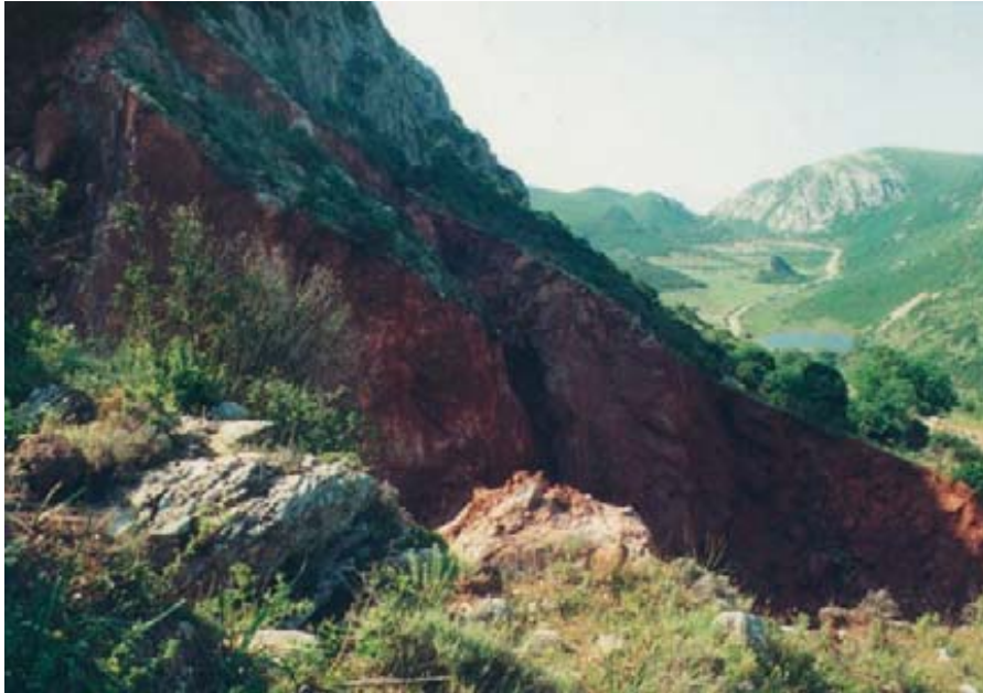
Fig.3 - Particolare della frana del 1991
