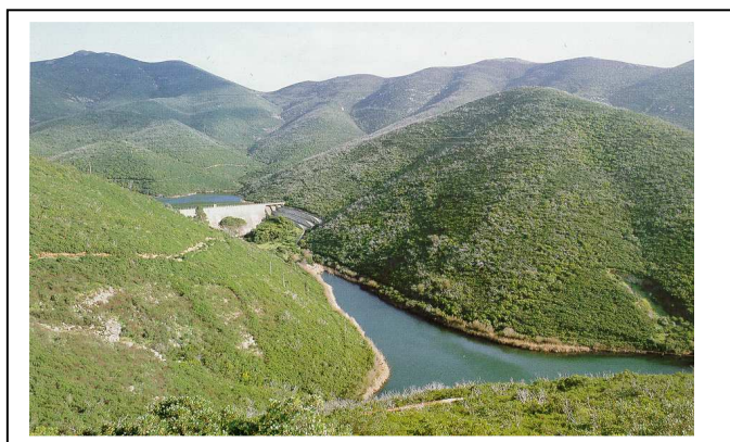
Vista dei bacini Donegani (a monte) e Zerbini (in primo piano)
