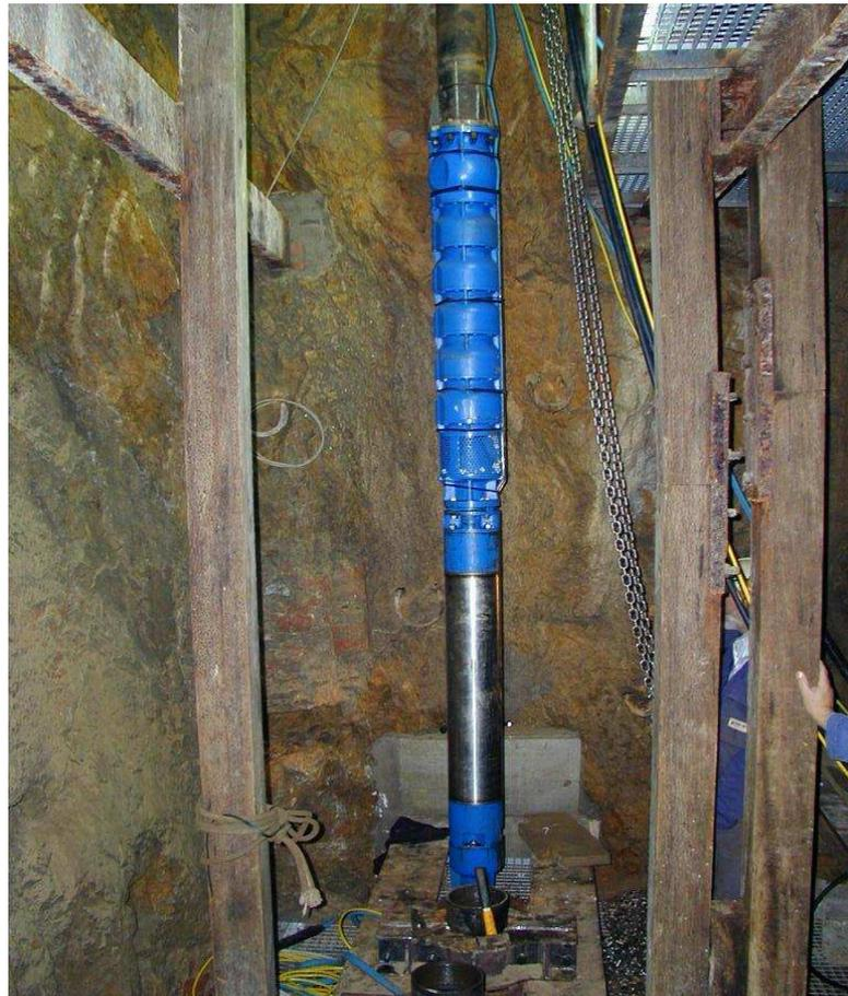
Fig. 8 Pompa sommersa ATURIA da 110 kW , 27 l/s e 190 m di prevalenza.
