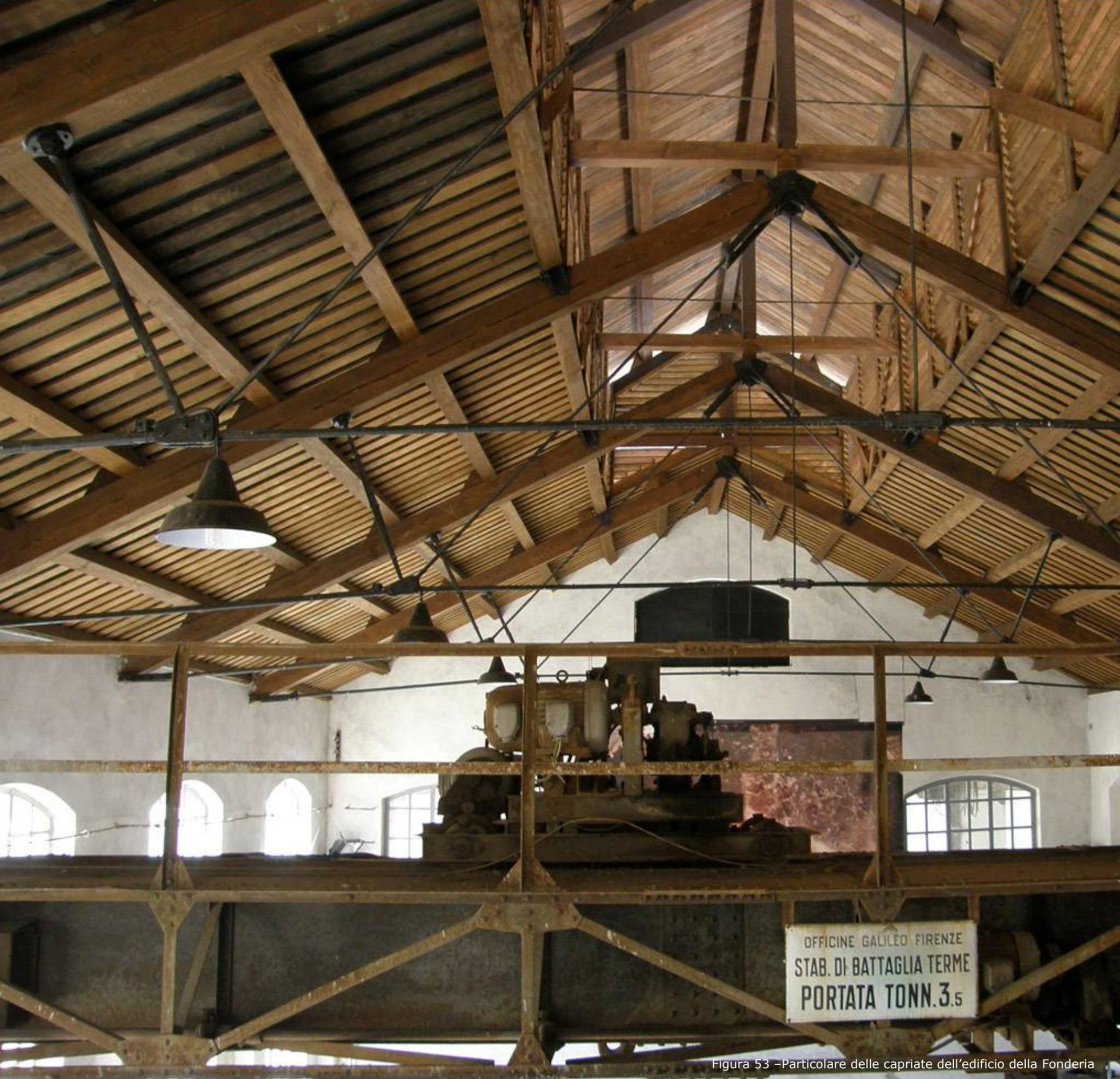
Figura 53 -Particolare delle capriate dell'edificio della Fonderia
