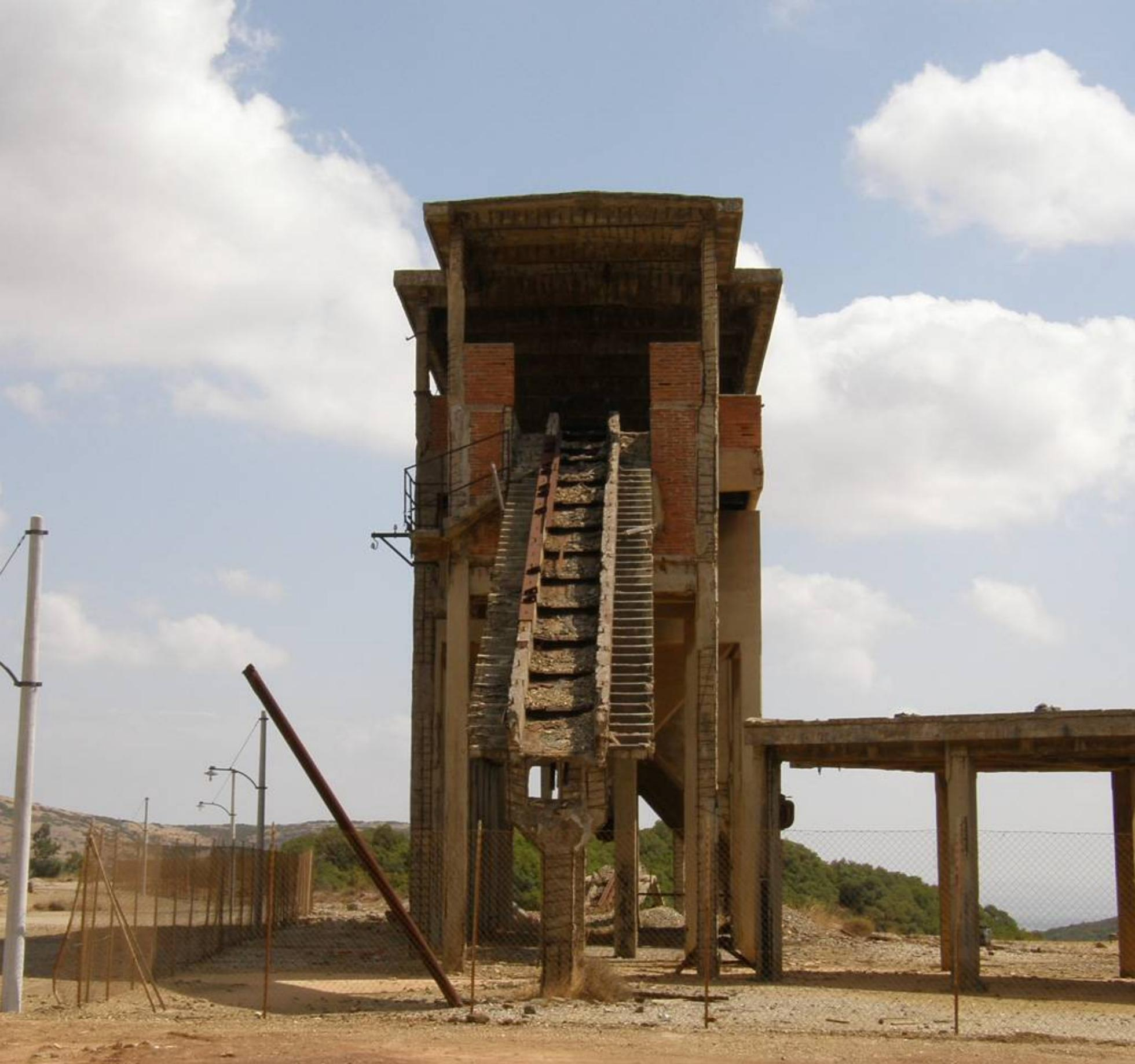
Figura 72 – Stazione di arrivo della teleferica, miniera di Montevecchio Levante
