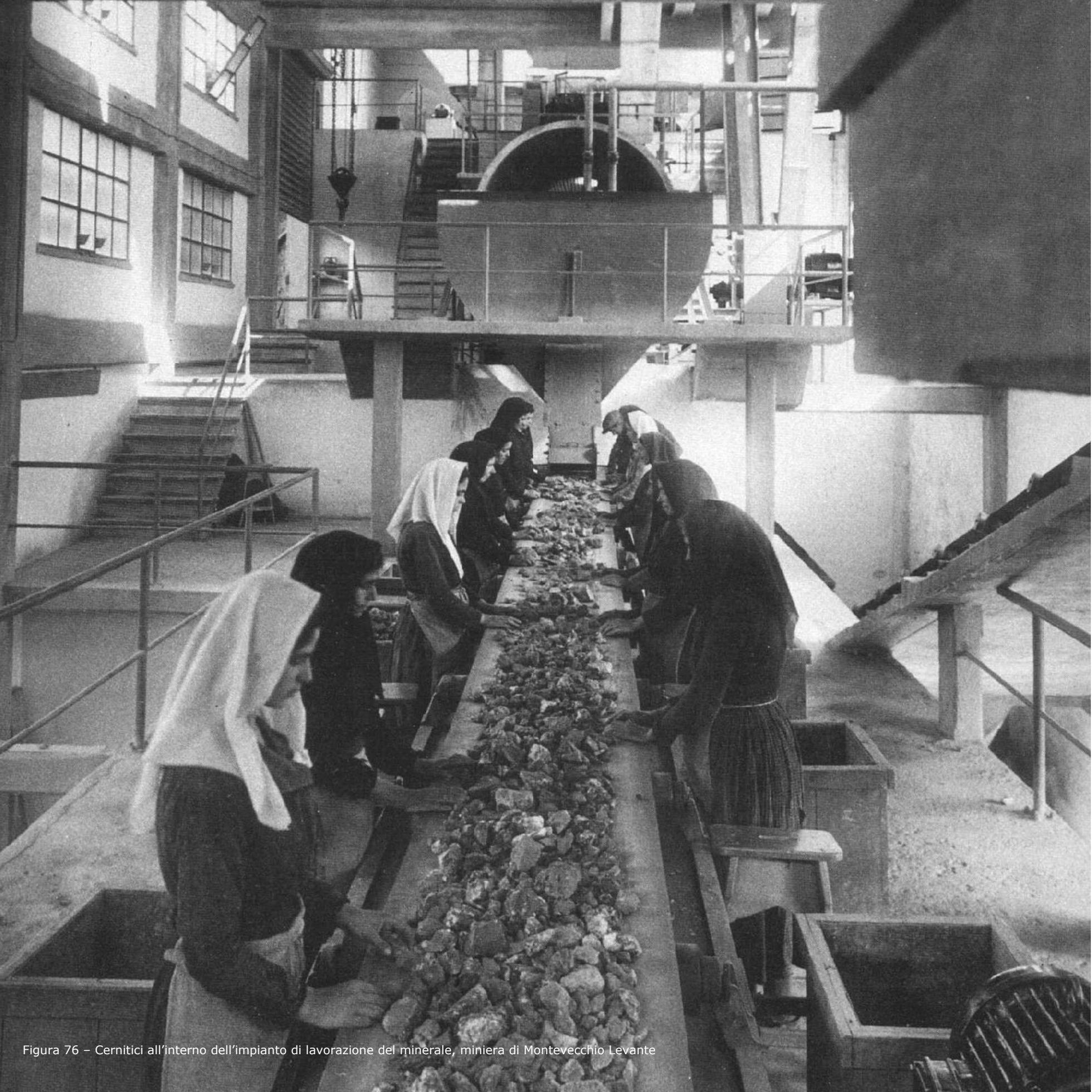
Figura 76 – Cernitici all'interno dell'impianto di lavorazione del minerale, miniera di Montevecchio Levante
