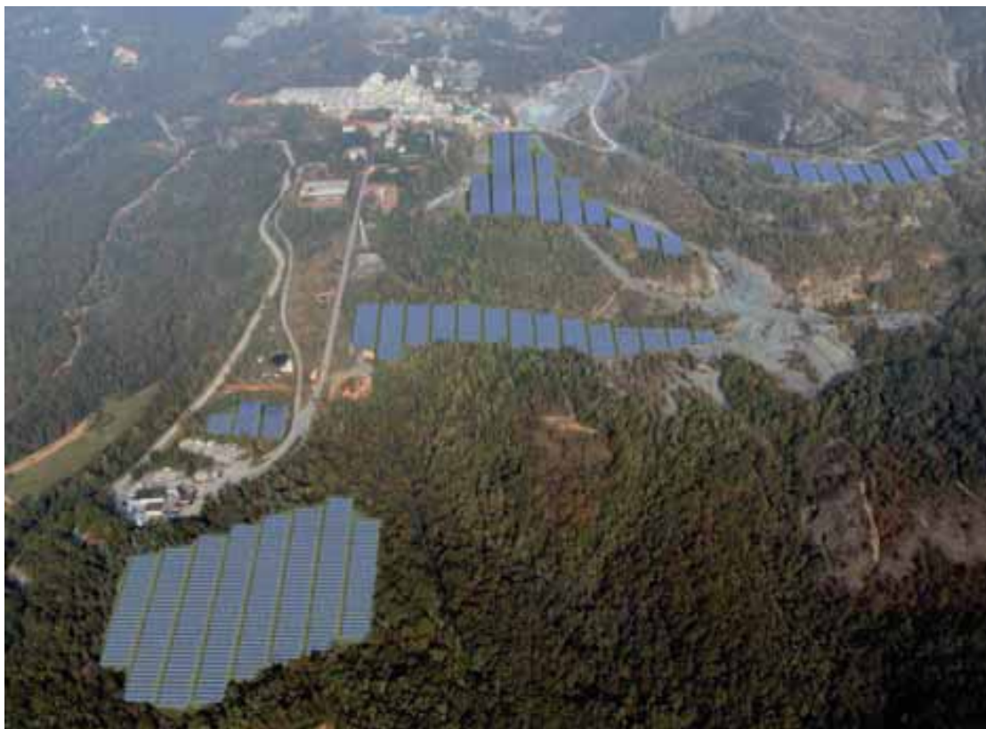
Figura 9. Progetto campi fotovoltaici
