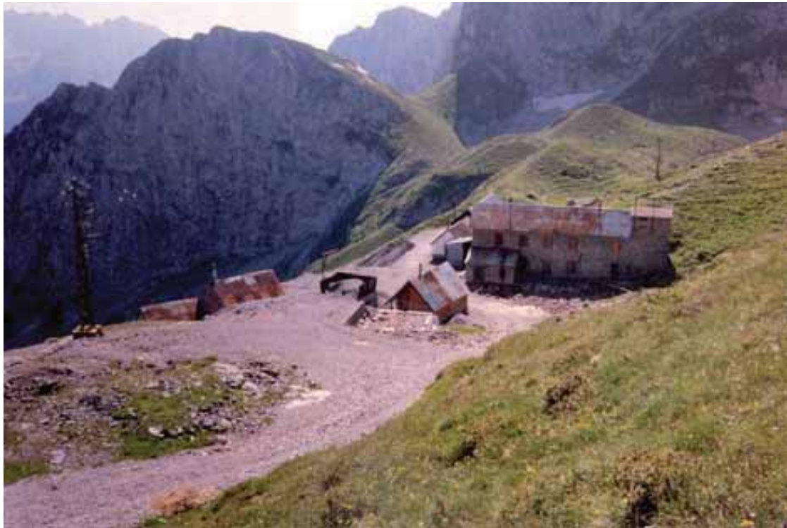
Figura 4. Miniera del Laghetto di Polzone, impianti esterni.
